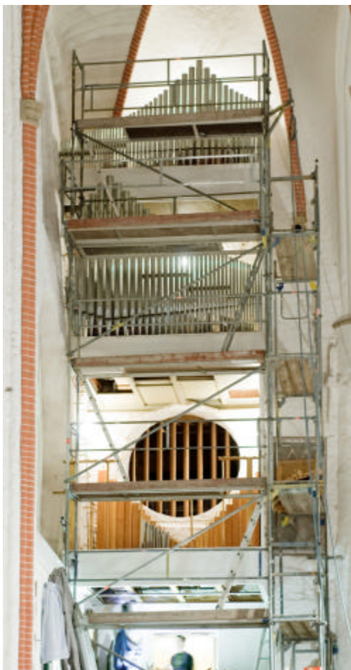
Hauptteil der Kemper-Orgel eingerüstet
